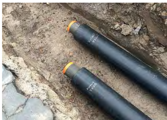
Oben: die offene Baugrube im Volltuchweg Unten: Kunststoffmantelrohre mit Wärmedämmung
